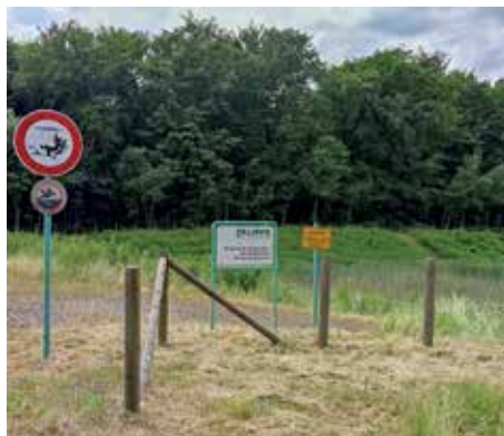
Regenrückhaltebecken des Lippeverbandes
