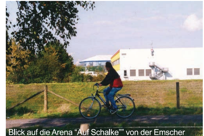
Blick auf die Arena "Auf Schalke" von der Emscher
