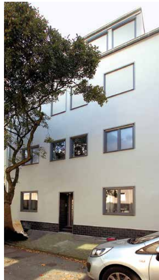
Ein neuer Anstrich gibt der Fassade den letzten Schliff.
