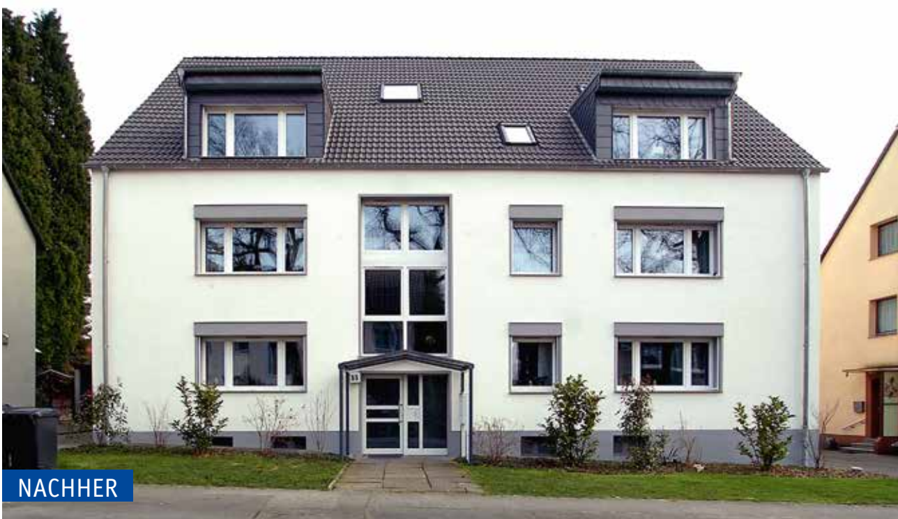
Ein modernes Äußeres trifft hier auf ausgefeilte Heiztechnik und eine energetische Sanierung.
