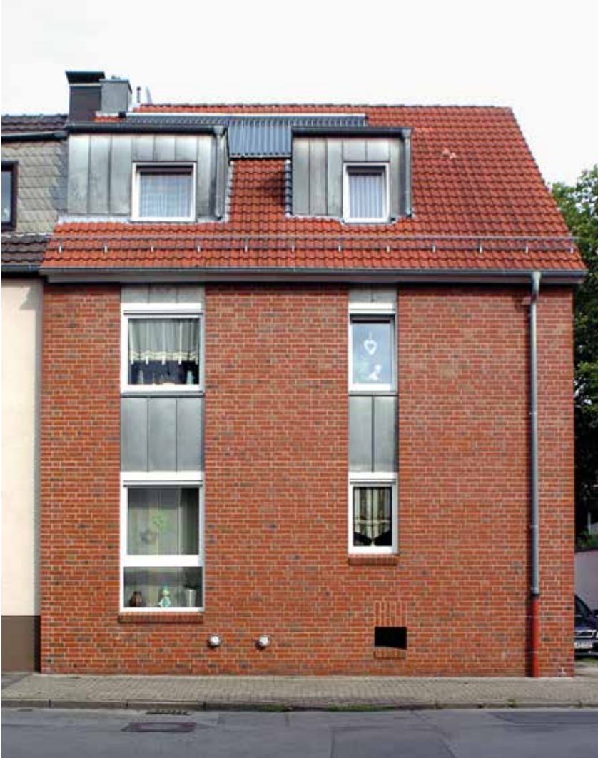
Über den Dachgauben wurde die effiziente Röhrenkollektoranlage installiert; sie sorgt für günstige Wärme von der Sonne.
