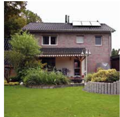
Neue Gemütlichkeit durch energetische Sanierung und neue Dachhöhe.
