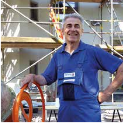
Altbau ist dank Sanierung nun energetisch auf Neubauniveau.
