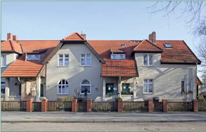
Eine Hauskette an der Steinmetzstraße. Man erkennt, wie wichtig die Fensterteilung für die Proportionen eines Hauses ist.
