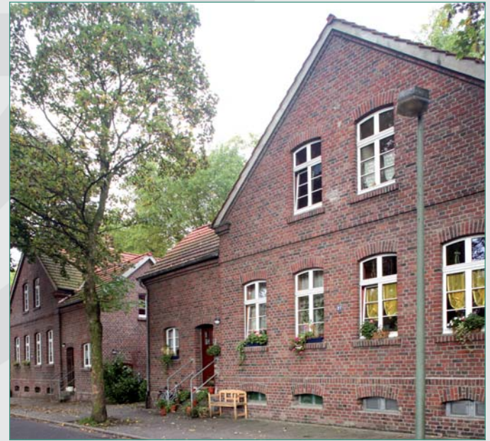
Alte Häuser an der Hugostraße. Die Geschosse sind höher und die Keller von innen zugänglich. Früher nicht selbstverständlich.
