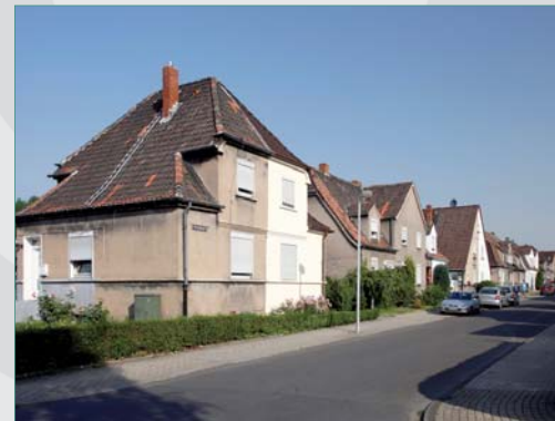
Gefahr der Einzelprivatisierung: un-abgestimmte Renovierungen.
