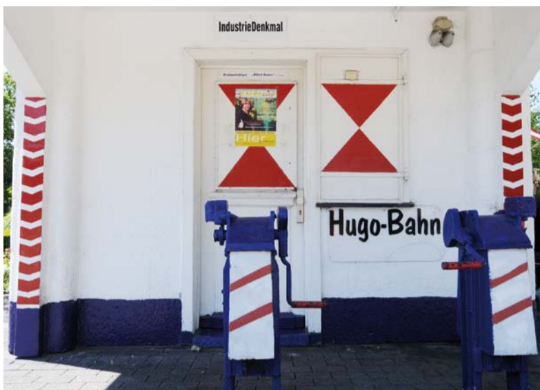
Ohne Don Alfredo wäre das Bahnwärterhäuschen längst abgerissen worden.
